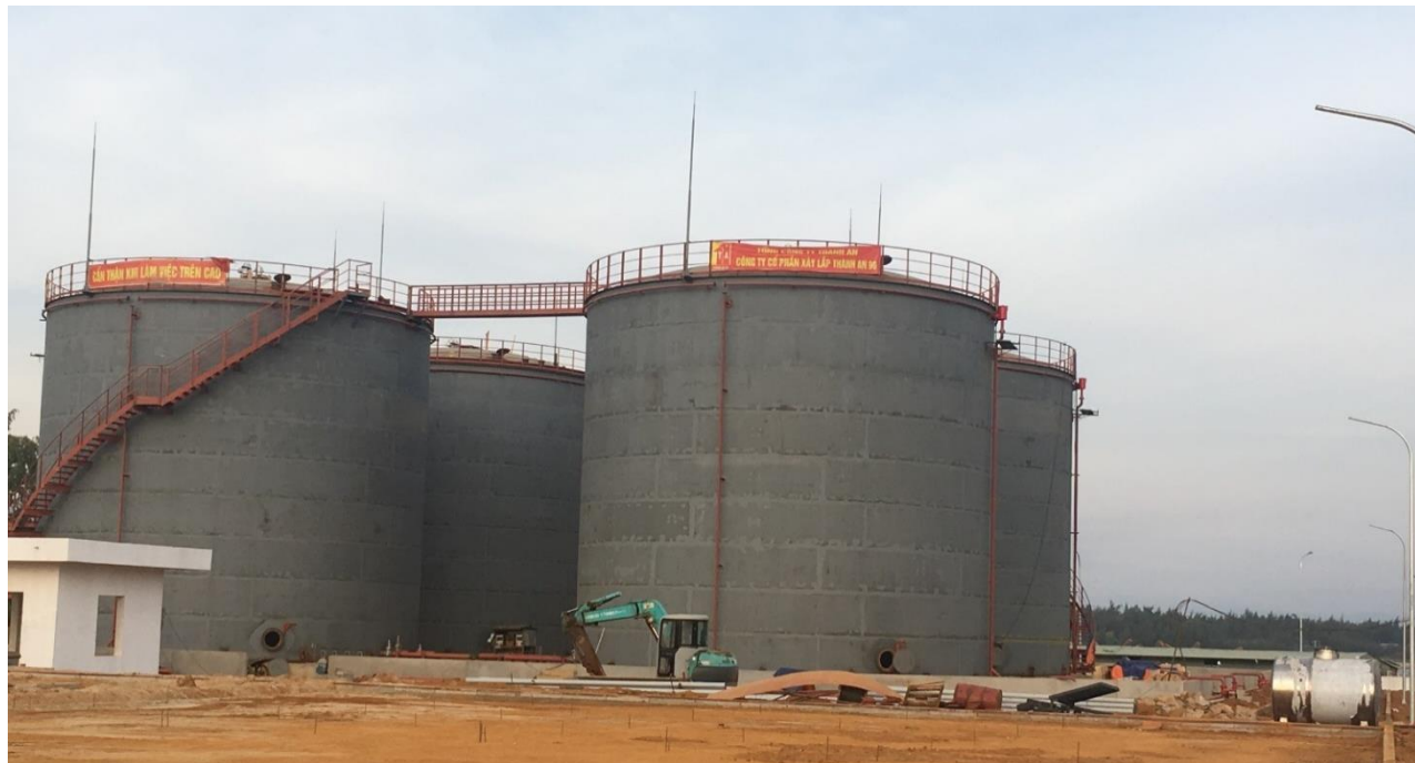
Cung cấp thiết bị, thi công lắp đặt bồn bể dự án kho Kỳ Hà tỉnh Quảng Nam
