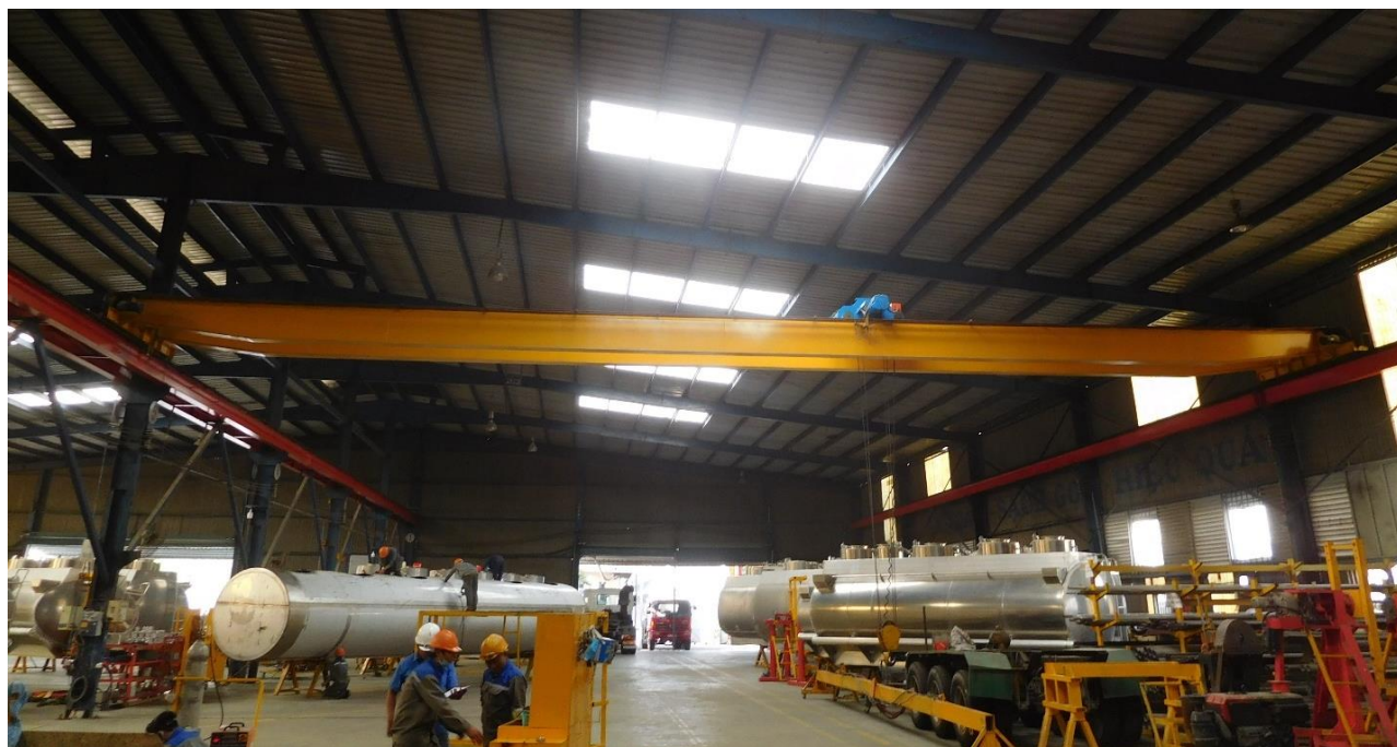
Cầu trục 7,5 tấn ( Xưởng A & B)
