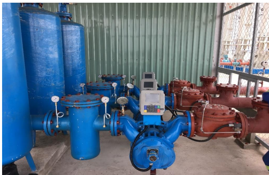
Cung cấp lưu lượng kế, xây dựng và lắp đặt đường ống cho dự án VK102
